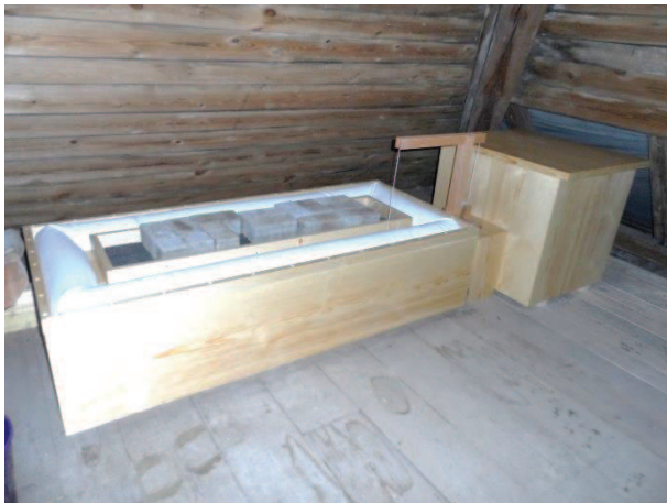
Neuer Schwimmerbalg mit Motorkasten und Rollenventil
